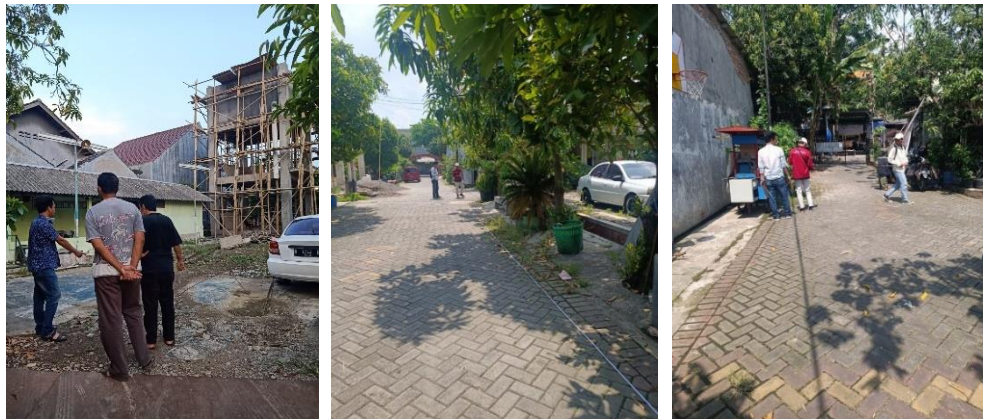
Gambar 2. Survey Lapangan dan Pengukuran Site
